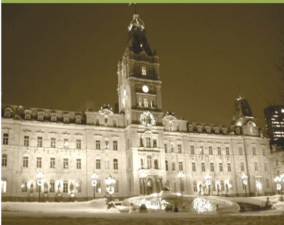
Façade de l'Hôtel du Parlement Bâtiment de style Second Empire inspiré du Vieux-Louvre
