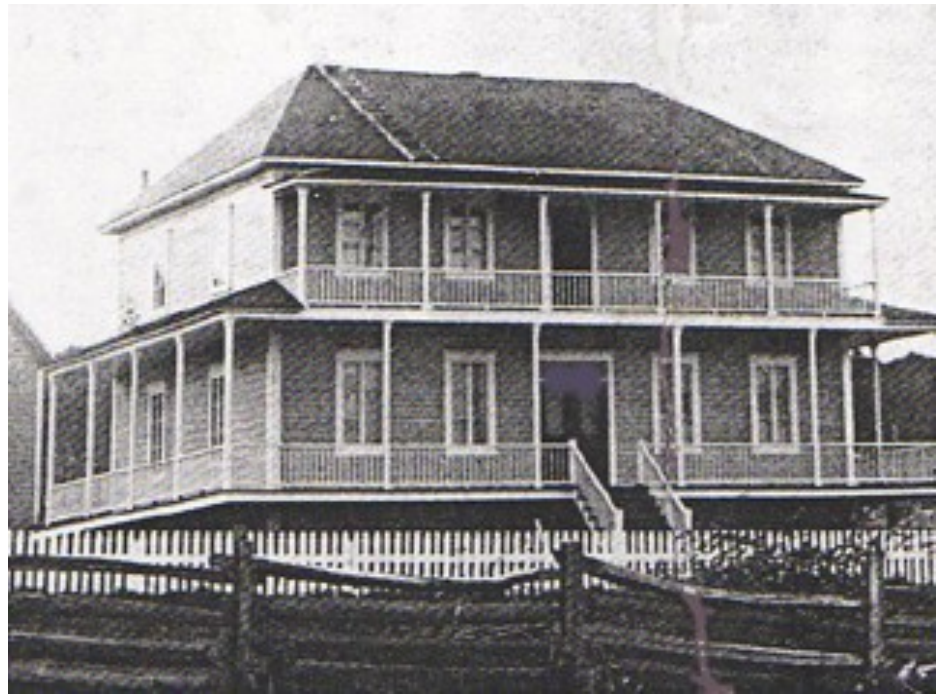
LA PREMIÈRE CHAPELLE-PRESBYTÈRE DE SAINT-LUDGER DE RISBOROUGH CONSTRUITE EN 1895
